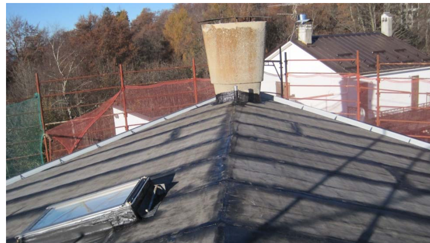
Foto cantiere in copertura
