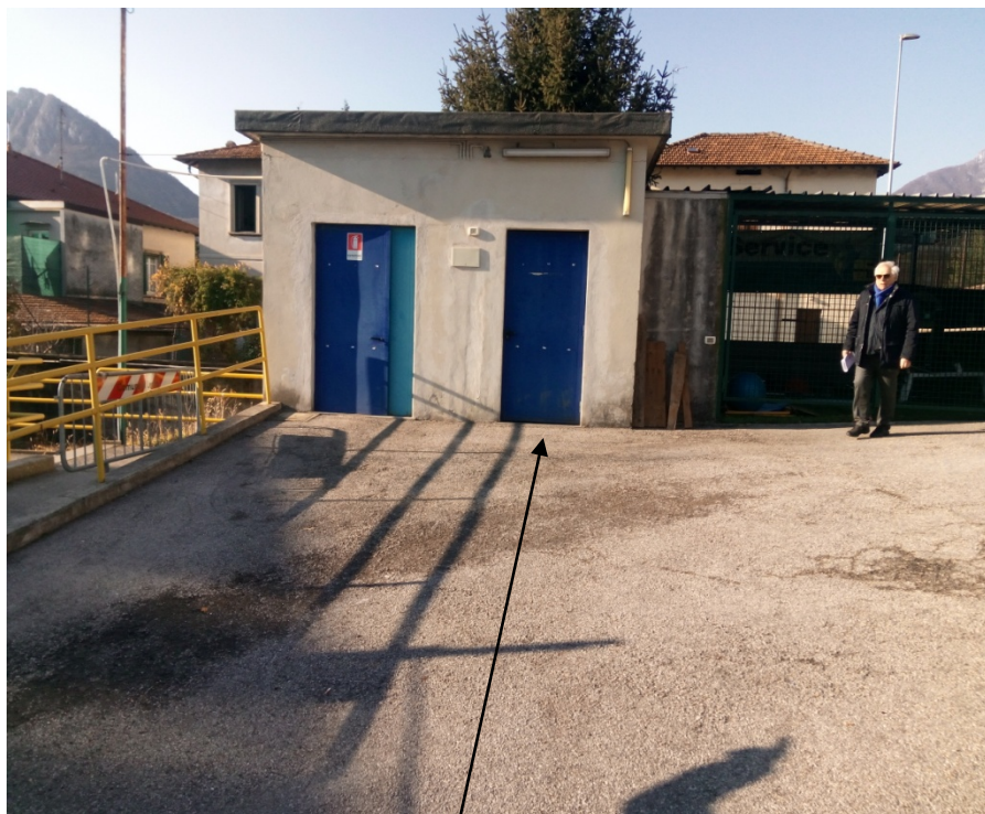
Bagno accessibile esistente (D.M. 236/89)
