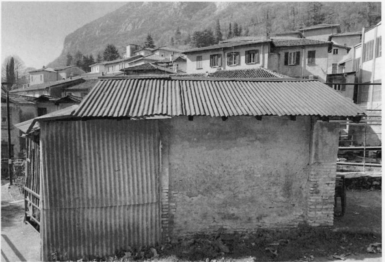
Prospetto est ex casello del custode
