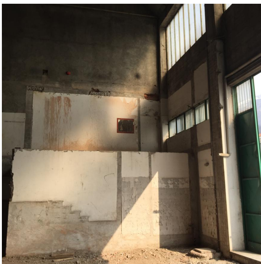
FOTO n. 17 – Interno Nuovo Capannone
