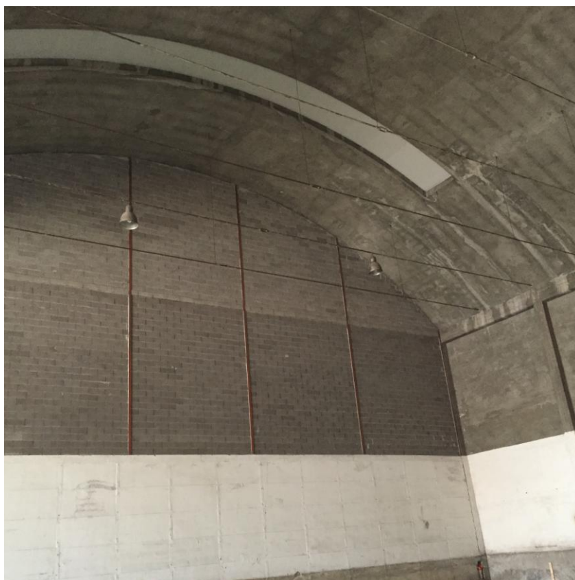
FOTO n. 15 – Interno Nuovo Capannone
