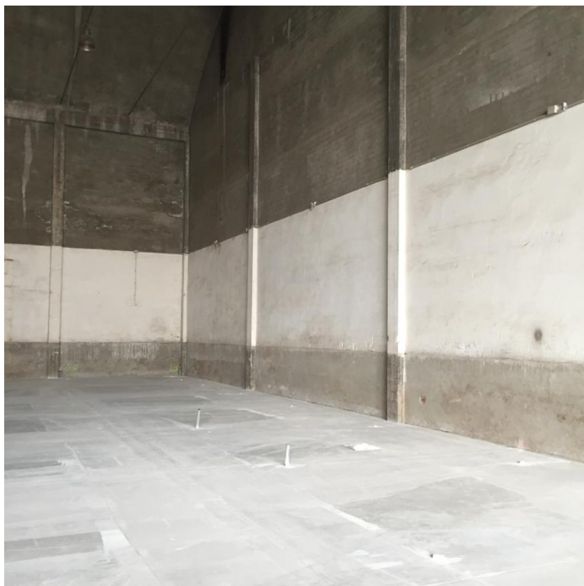
FOTO n. 16 – Interno Nuovo Capannone
