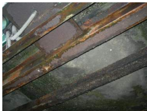
Ancoraggio sul profilato a sbalzo del palo di illuminazione e relativo cavidotto
