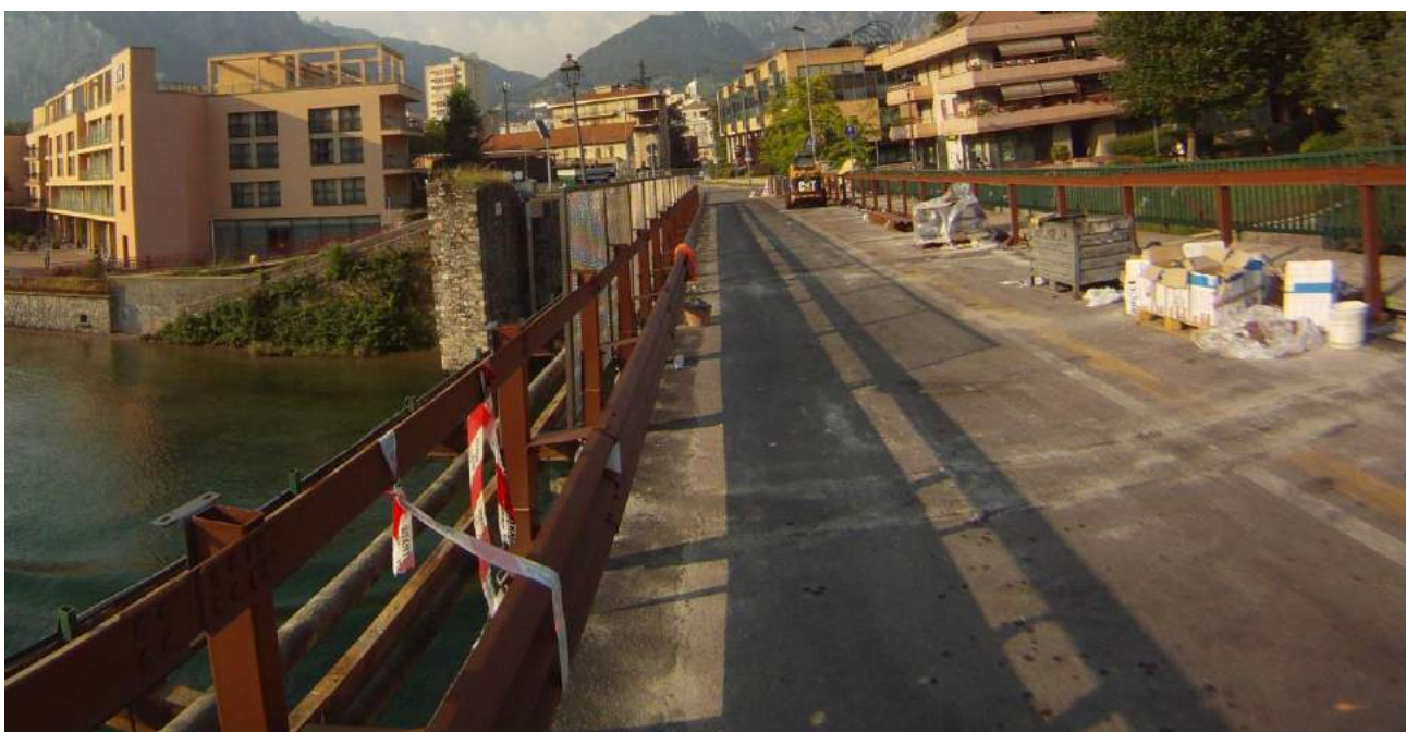
Il Ponte Visconti durante la realizzazione della nuova barriera
