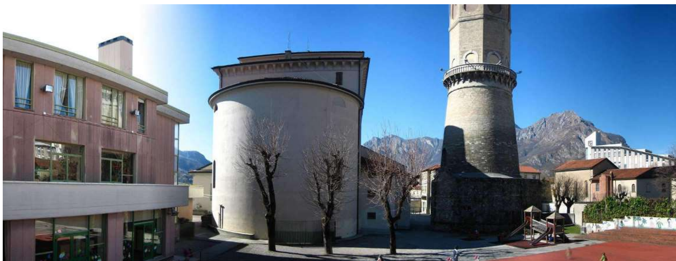
13 VISTA DELLA SCUOLA DELL'INFANZIA, CAMPO GIOCO, BASILICA E TORRE CAMPANARIA
